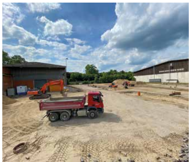
Die Erdarbeiten sind fast abgeschlossen. Der neue Hof wird viel Platz für komfortables Anliefern bieten.
