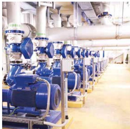
■ 12 Hochleistungspumpen sind für die Abwasserbeförderung der Filtration zuständig.
